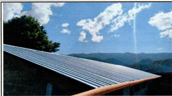
Foto 1: MEJORAMIENTO DE ENTECHADO, SUSTITUYENDO LAMINAS VIEJAS Y DETEREORADAS POR LAMINAS TROQUELADAS
