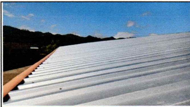
Foto 2: MEJORAMIENTO DE ENTECHADO, SUSTITUYENDO LAMINAS VIEJAS Y DETEREORADAS POR LAMINAS TROQUELADAS
