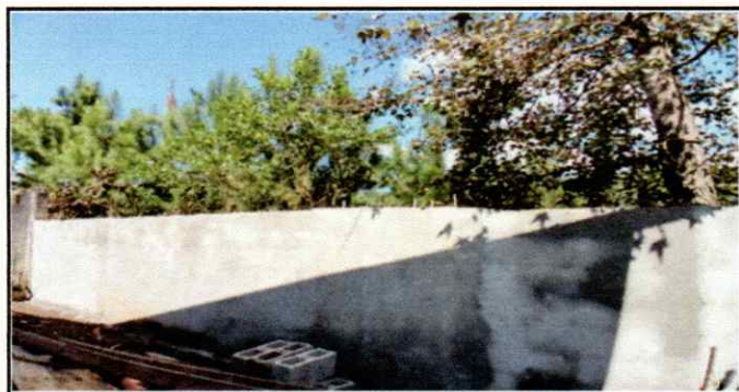
Foto 5: REPARACIÓN DE MURO PERIMETRAL
