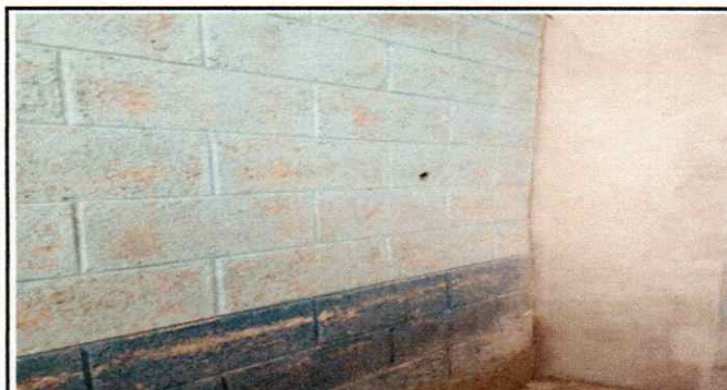
Foto 6: REPARACIÓN DE PAREDES.
