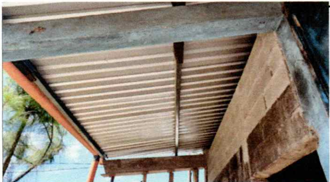
Foto 3: ELEVACIÓN DE PAREDES DE LA COCINA.
